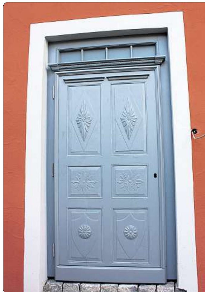
Kunstvolle Ornamente zieren die Original-Haustür – viel zu schade zum Entsorgen. Sie wurde originalgetreu aufbereitet und präsentiert sich jetzt einladend, wärmedämmend und dank Dreifach-Verriegelung einbruchssicher. Foto: -eck
